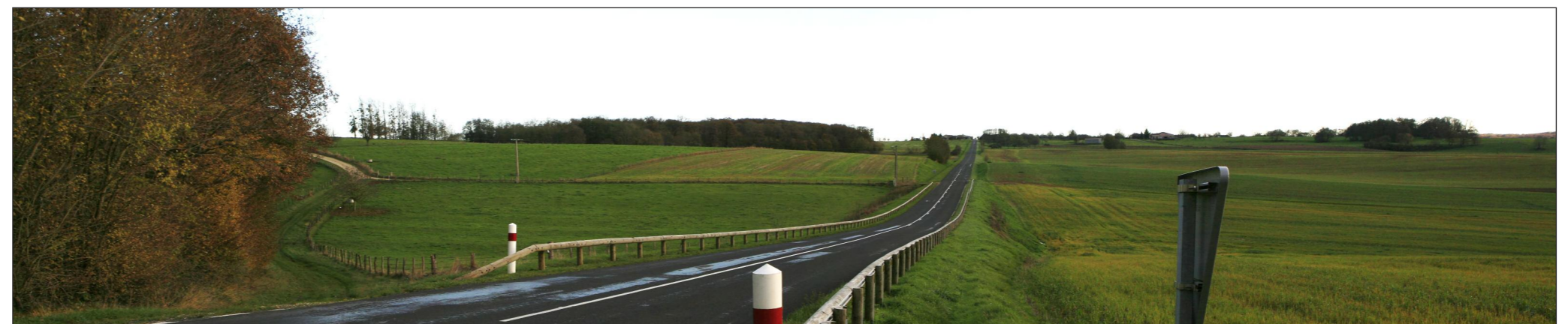
Vue du site avant projet
